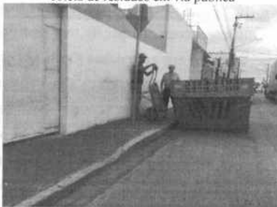
Figura 18. Caçamba estacionária disposta para coleta de resíduos em via pública
